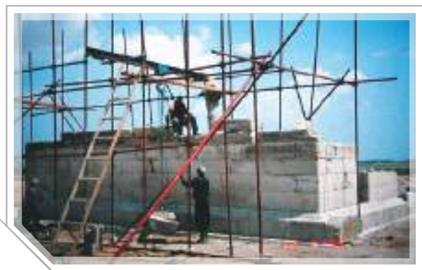
Travaux de reconstruction du temple dans son site d'accueil à la périphérie du barrage
