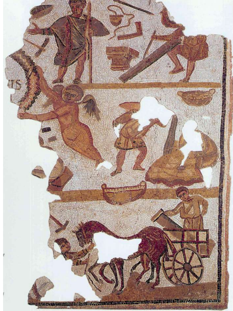
Fig. 7. — Scène de construction. Annexe de l'église de Wadi Arremel. (musée national du Bardo)
